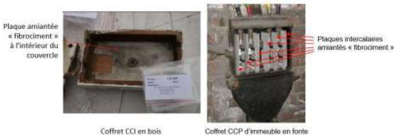
Les colonnes électriques en tubes et les coffrets et distributeurs d'étage en bois n'ont aucune évolutivité possible.
