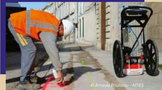
Marquage au sol du réseau électrique après sa détection par un radar mono-antenne.
